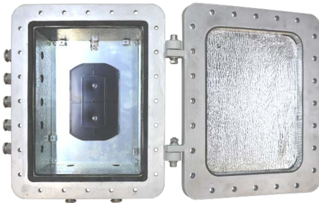
Рисунок 5. Сплайс-кассета коммутатора
